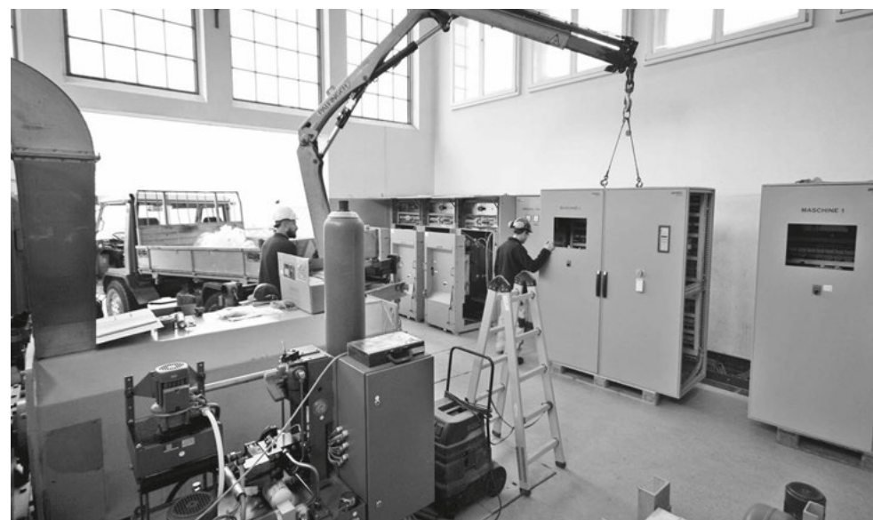
Ersatz der Steuerungsanlage im Kraftwerk Sustli.
