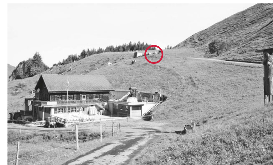
Standort Pumpwerk Tannibüel.
