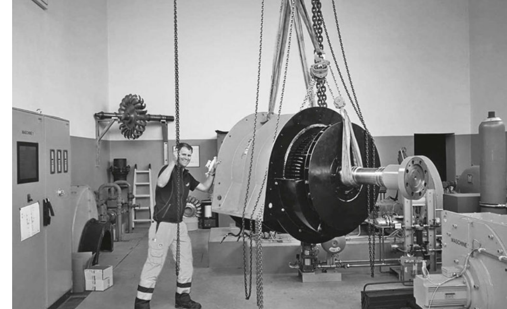
Montage des Generators
