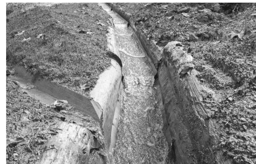
Naturnahe Holzkanäle führen jetzt die Wasserläufe.
