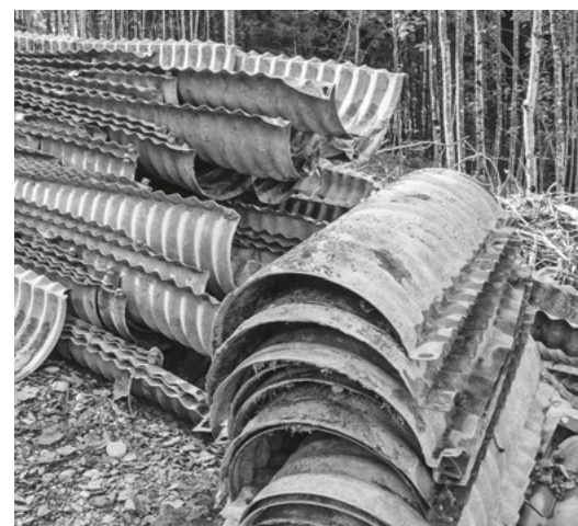
Stahlschalen werden ausgebaut.
