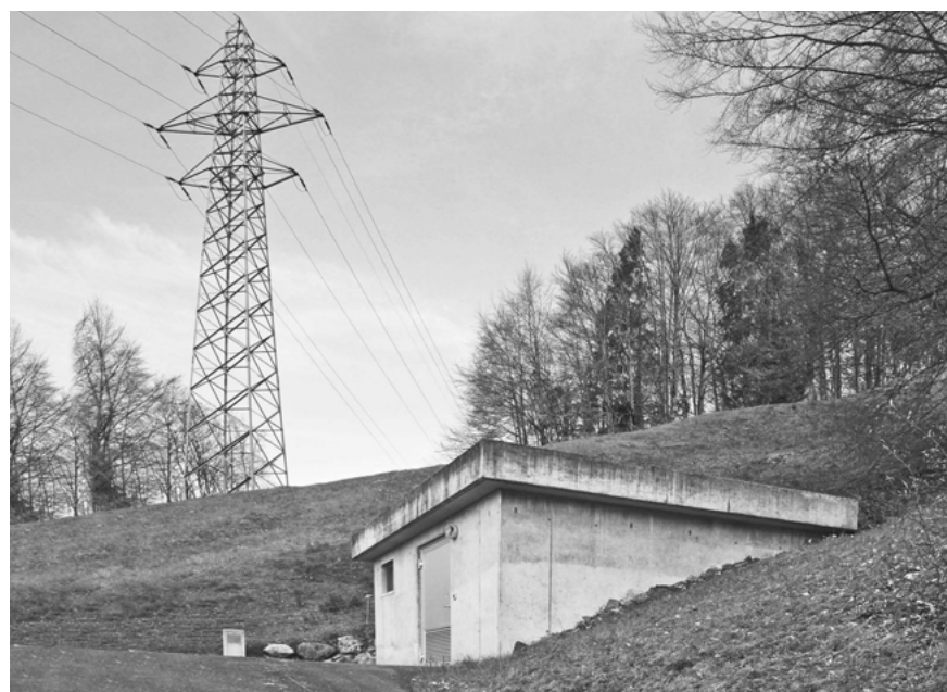
Trinkwasser-Kleinkraftwerk Lätten Bild: Peter Feldmann (Beckenried, 27. April 2012)
