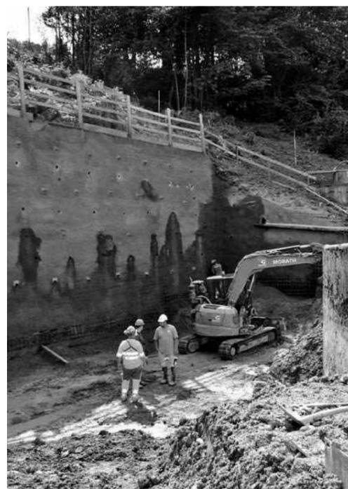
Aushubarbeiten für die Kraftwerkszentrale Napf.
