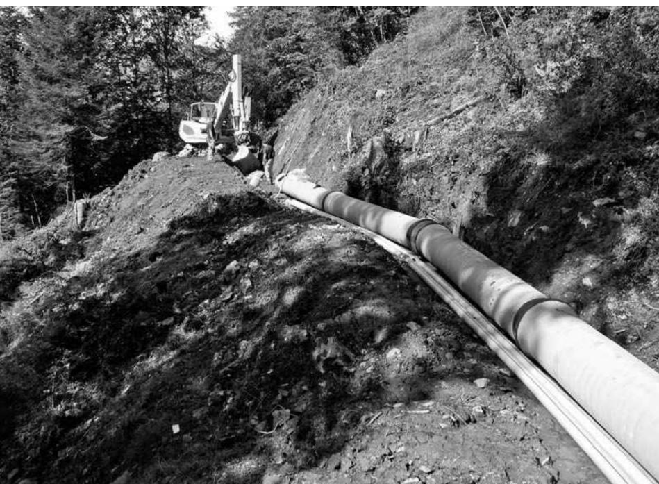
Rohrleitungsbau im Staldiwald. Guss-Druckleitung mit Durchmesser 600 mm.
