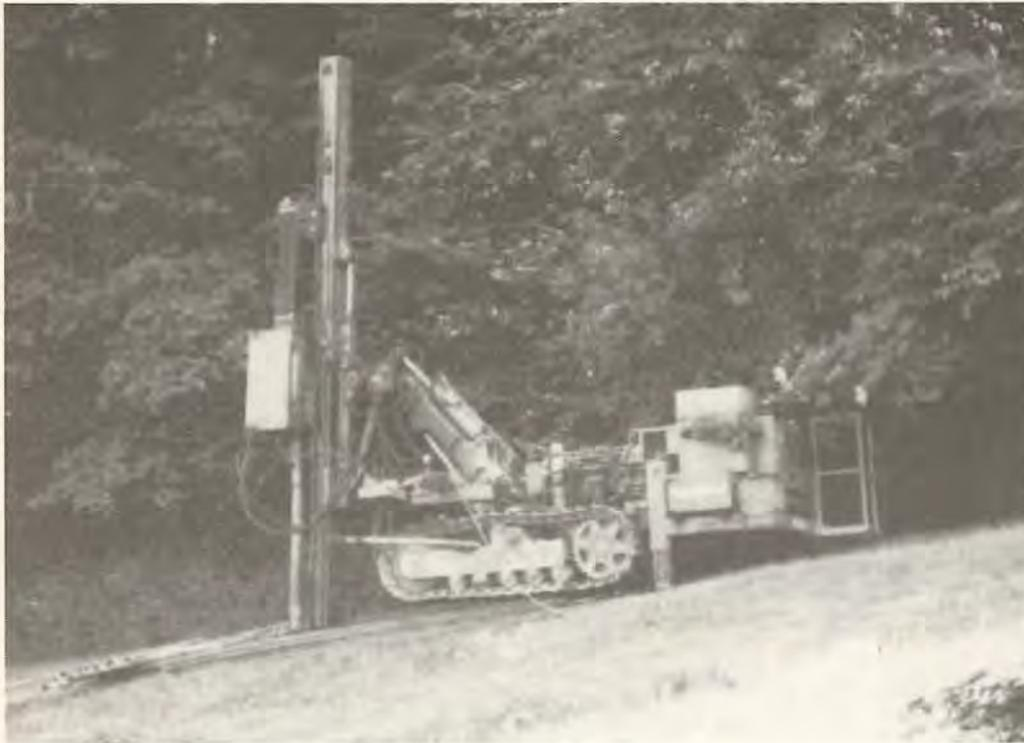
Bohrgerät für Kernbohrungen
