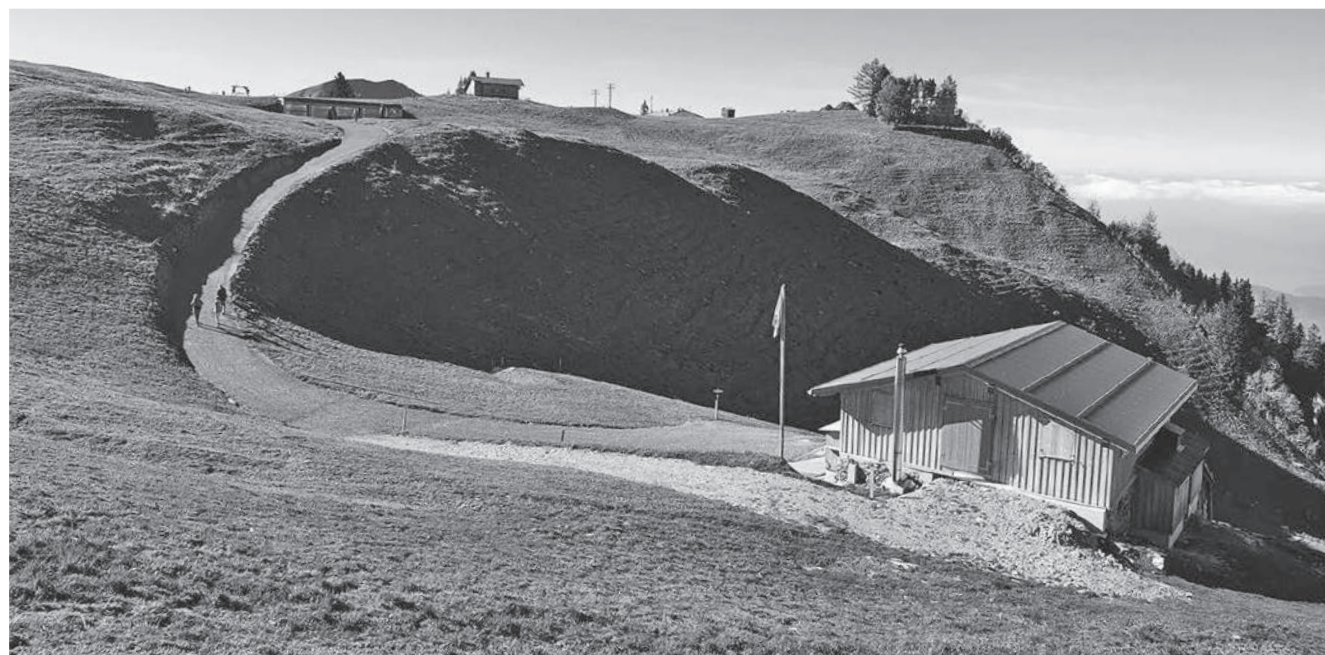
Sanierte Zufahrtsstrasse zur Alphütte Klewen.
