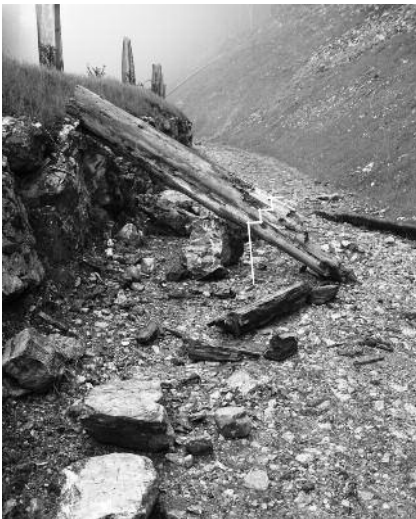
Der neu erstellte Schuttdamm beim Obersassi wurde im Juni durch die Regenfälle bereits ein erstes Mal intensiv «benutzt».
