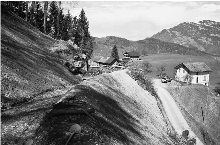
Bauarbeiten am Schuttdamm
