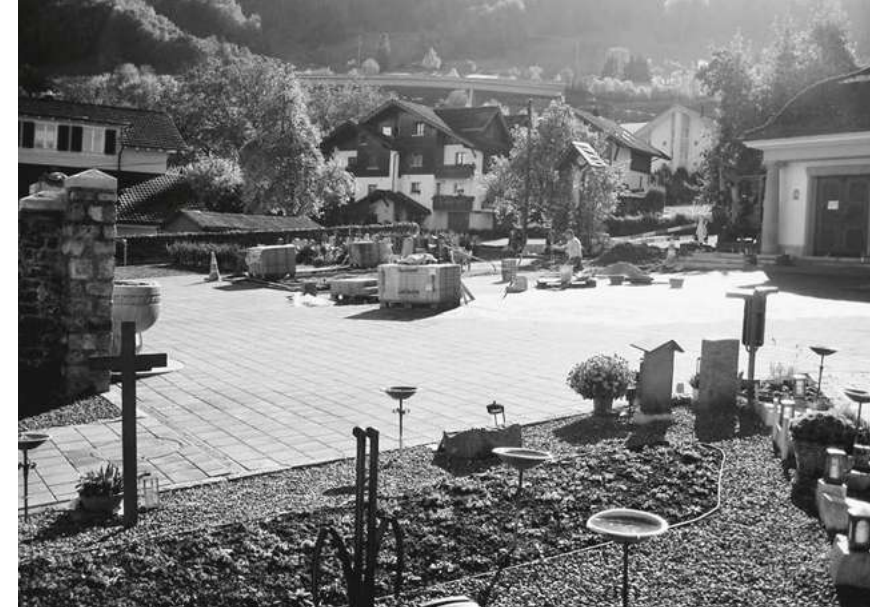
Fast fertig erstellter Vorplatz vor der Abdankungshalle.
