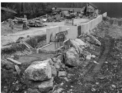
Im Unterlauf konnten die Bauarbeiten im Herbst 2023 gestartet werden. Aufgrund einer öffentlichen Ausschreibung konnte dieser Auftrag an die PK Bau AG vergeben werden. In einer ersten Phase wurde der Bachlauf im Deltabereich neu gestaltet. Zusammen mit dem Einbau des Rauhbettgerinnes wurden auch die Seitenschutzmauern im Bereich des Strandbades erstellt. Oberhalb der Kantonsstrassenbrücke musste die dorfseitige Böschungsmauer auf einer Länge von rund 100 m ersetzt werden.
