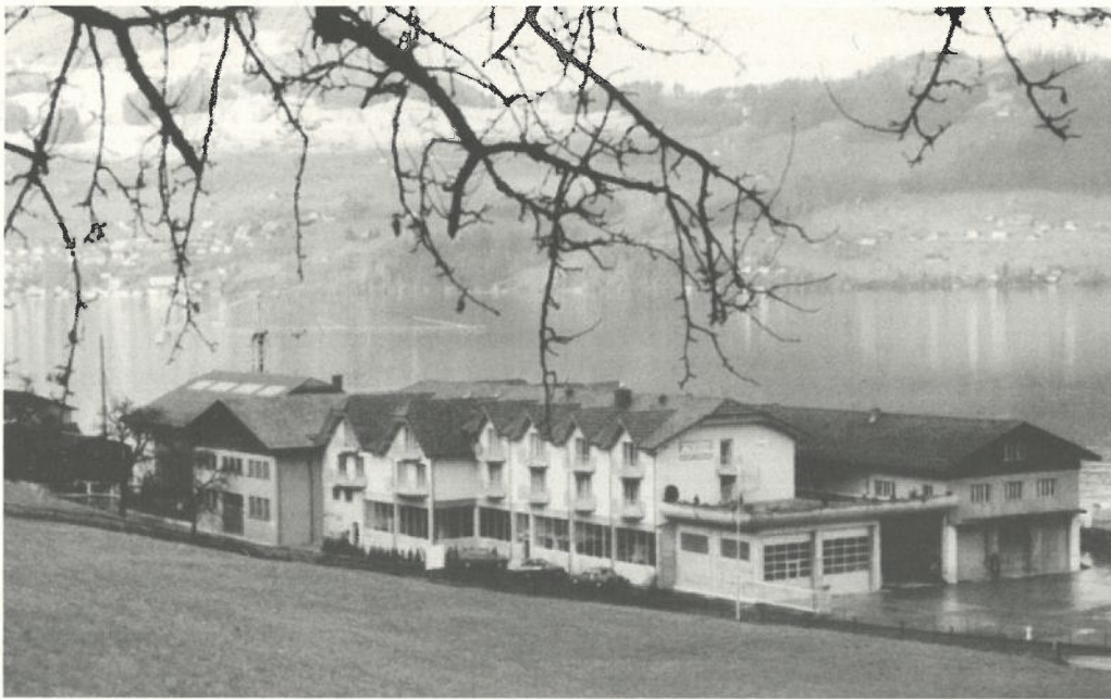
Der Werkhof «Neuseeland» nach dem Um-/Neubau 1991/92 mit Personal-Unterkunft
