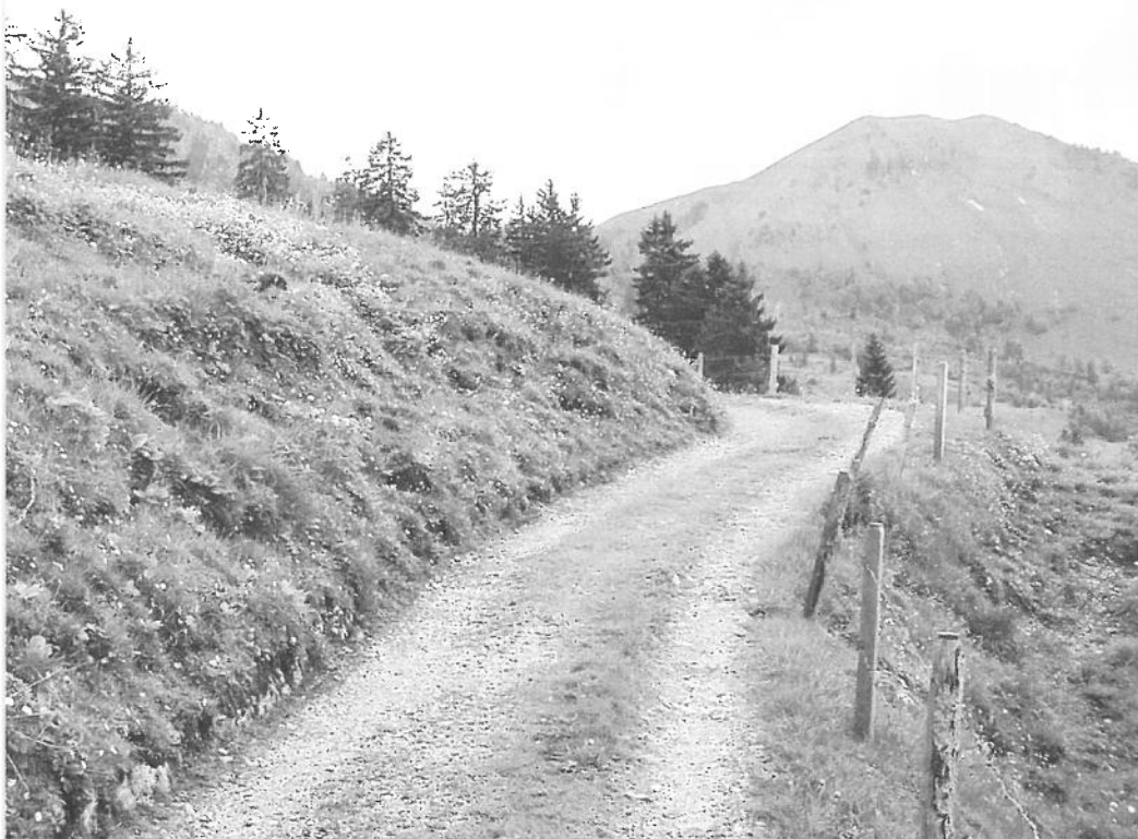
Sanierung Zufahrt vorder Graben–hinter Graben
