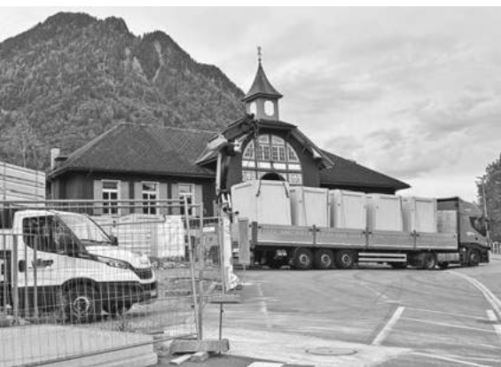
Behälter werden geliefert.
