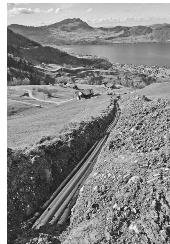
Verlegung der Druckleitung im Bereich Hartmanix – Chisti.
