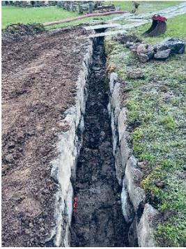
Am Röhrlibach wurde eine erste Etappe an Unterhaltsarbeiten ausgeführt. Bei Starkniederschlägen bestand bisher die Gefahr des Ausuferns des Baches. Mit den ausgeführten Unterhaltsarbeiten konnte dieses Problem behoben werden. Es wurden alte Natursteine vom Lielibach benutzt. Damit konnten lange Transportwege vermieden werden.
