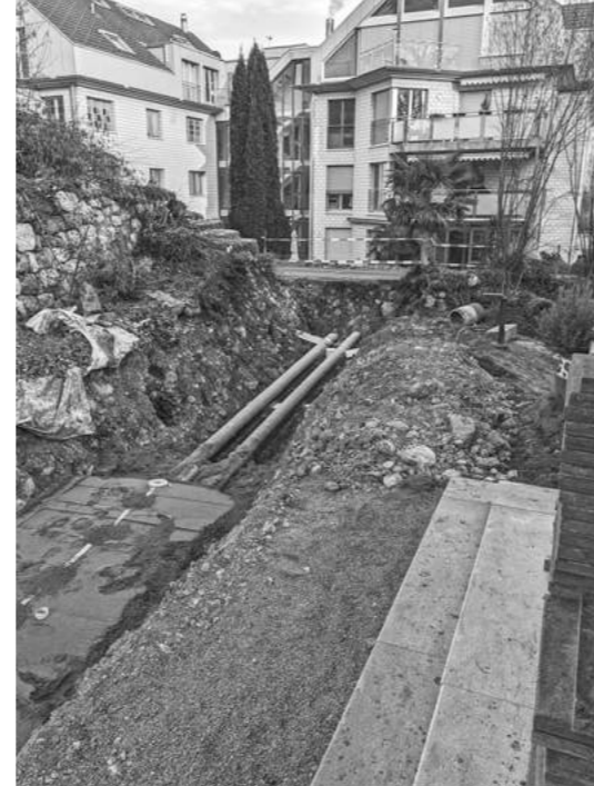
Leitungsbau im Bereich Minigolf, Erlen. Bild: Martin Würsch (Erlen, 8.2.2025)
