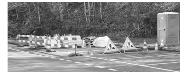
Erste Vorbereitungsarbeiten (Sondierbohrungen).
