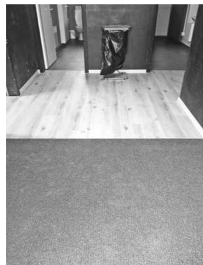
Lieli Eingang neue Schmutzschleuse.
