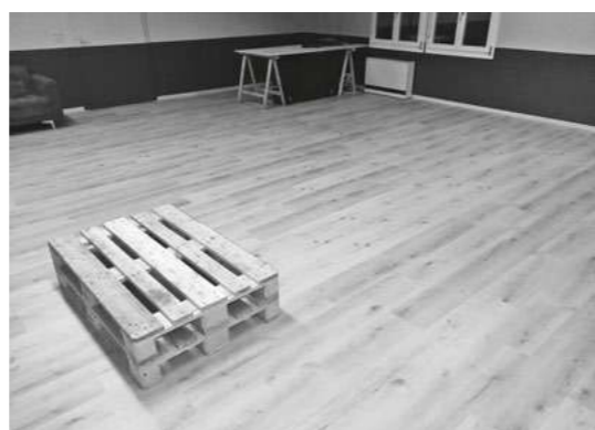
Lieli neuer Bodenbelag Saal I.
