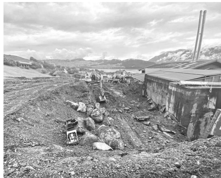
Aushub für Erweiterung Schnitzelbunker und Platzierung Wärmespeicher.
