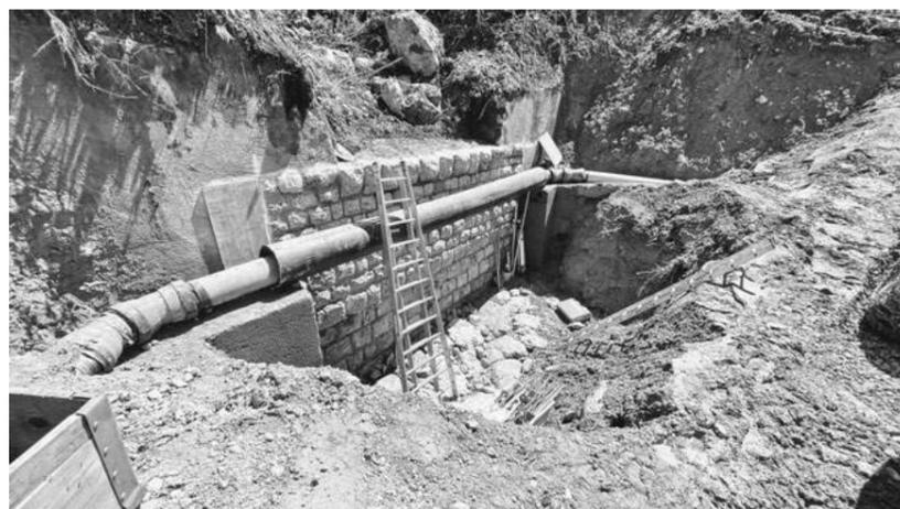
Querung Grabenbach: die Druckleitung wird bei einer bestehenden Schwelle einbetoniert.
